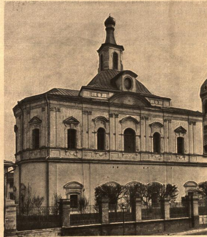
Церковь Воскресенія въ Барашкѣ на Покровѣ. 1732—1734 г.
