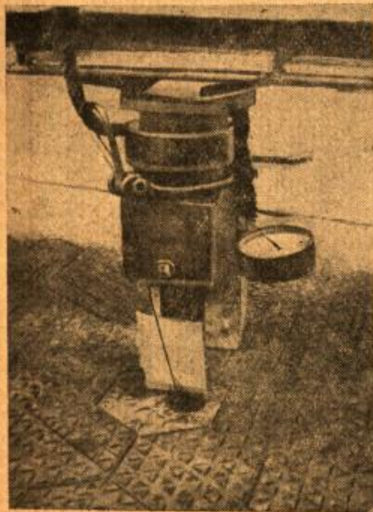
Рис. 11. Деталь установки для испытания под домкратом участка чугунных плит, укладываемых на песке. Видна проволока, прикрепленная к цилиндру и к прогибому для измерения просадки пола.
