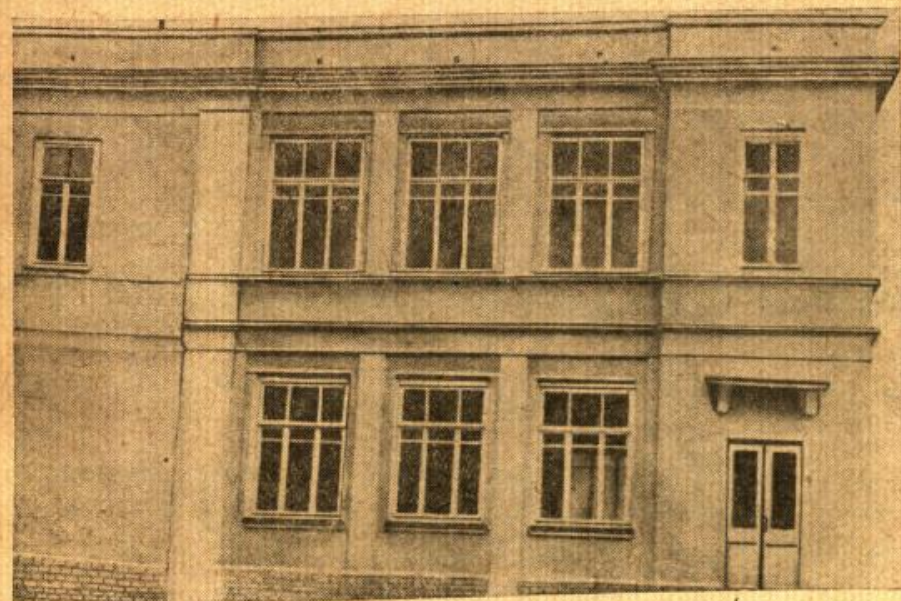
Рис. 9. Здание лаборатории Горьковского института из мелких гипсовых блоков системы Булычева.
