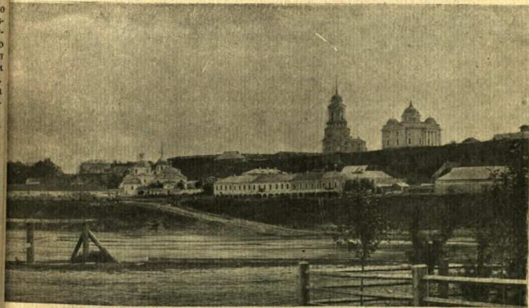
1. СТАРИЦА. Общий вид левой стороны города (с противоположного берега Волги) до немецкой оккупации. Фото Московского архитектурного института
