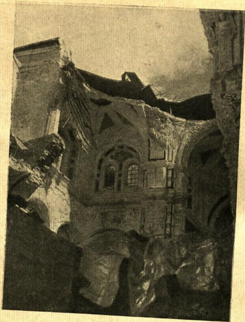
5. ИСТРА. Разрушенная центральная часть собора
