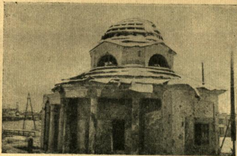
8. ТОРЖОК. Часовня Борисоглебского монастыря на Площади 9 января, разрушенная немецкими захватчиками
