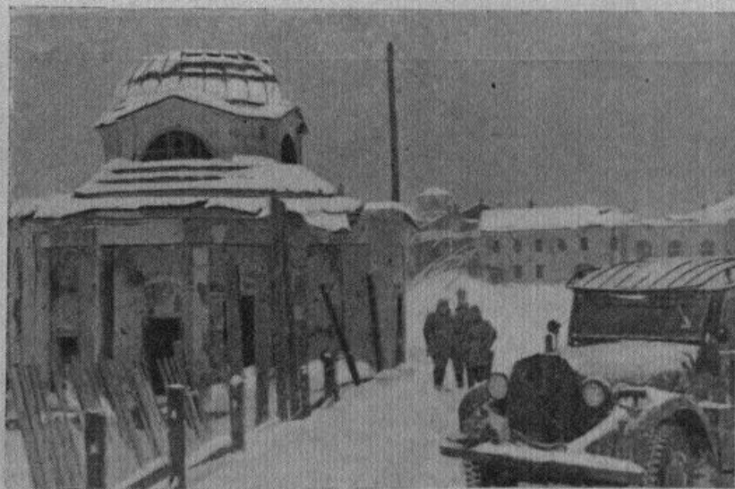
9. ТОРЖОК. Часовня Борисоглебского монастыря на Площади 9 января, разрушенная немцами
