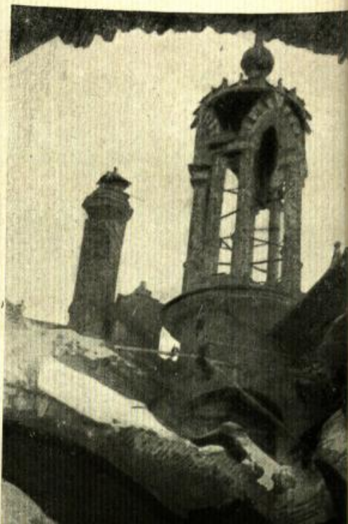
5. МОЖАЙСК. Никольский собор. Внутренний вид на разрушенный коробчатый свод б. Скорбященского придела. Вверху, через разрушенный свод видна угловая северо-западная главка собора. Снято в марте 1942 г. Фото арх. Н. П. Травникова
