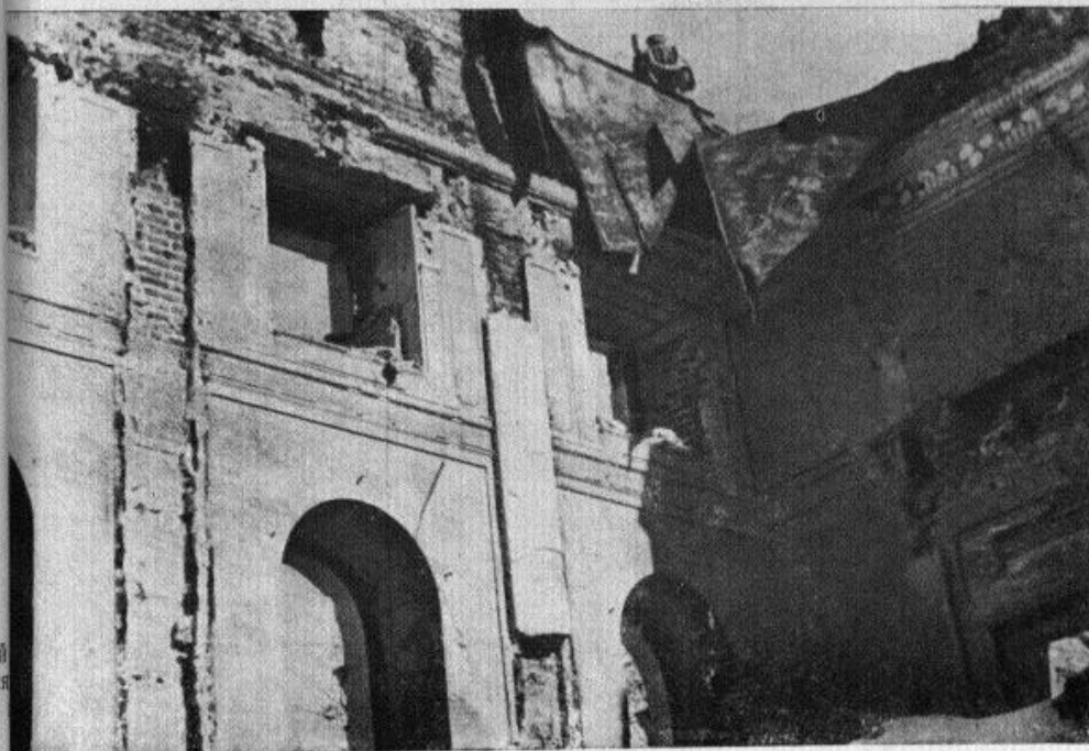
8. КАЛИНИН. Здание облсполкома (б. Путевой дворец). Интерьер главного зала после разрушения. Фото Н. Виноградова, Март 1942 г.
