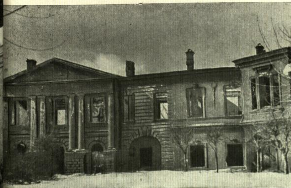
9. КАЛИНИН. Здание облисполкома (б. Путевой дворец). Боковой павильон после разрушения. Арх. К. Росси. Фото Н. Виноградова. Март 1942 г.
