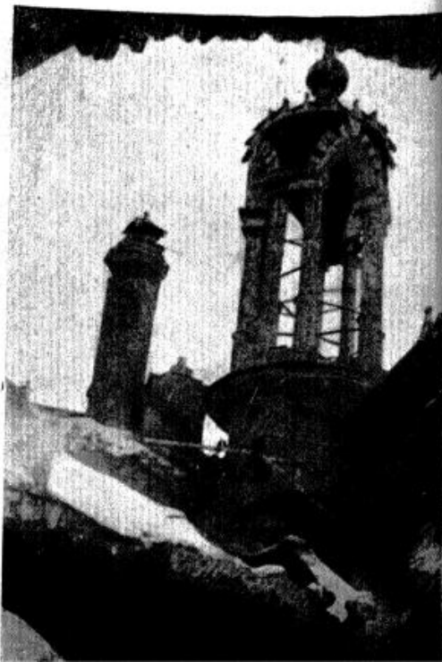
5. МОЖАЙСК. Никольский собор. Внутренний вид на разрушенный коробчатый свод б. Скорбященского придела. Вверху, через разрушенный свод видна угловая северо-западная главка собора. Снято в марте 1942 г. Фото арх. Н. П. Троицкого
