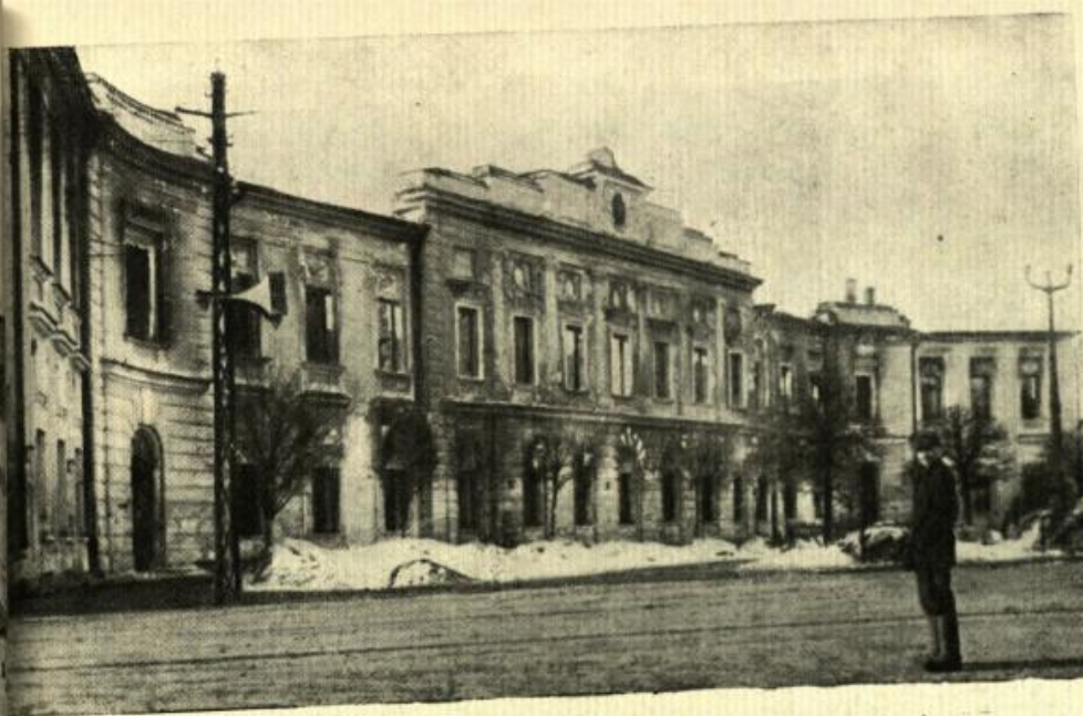
12. КАЛИНИН. Здание облсуда (б. «Присутственные места»). Арх. М. Ф. Казаков, 1763—70 гг. Общий вид здания. Фото В. Подключникова. Апрель 1942 г.
