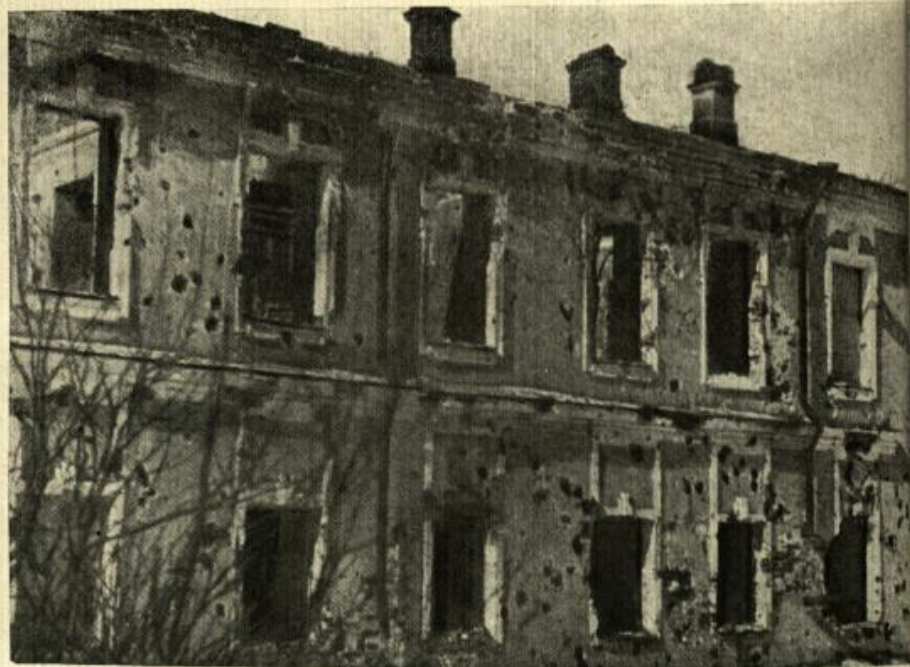
10. КАЛИНИН. Здание облсполкома (б. Путевой дворец). Восточная стена дворца после разрушения. Фото Н. Виноградова. Март 1942
